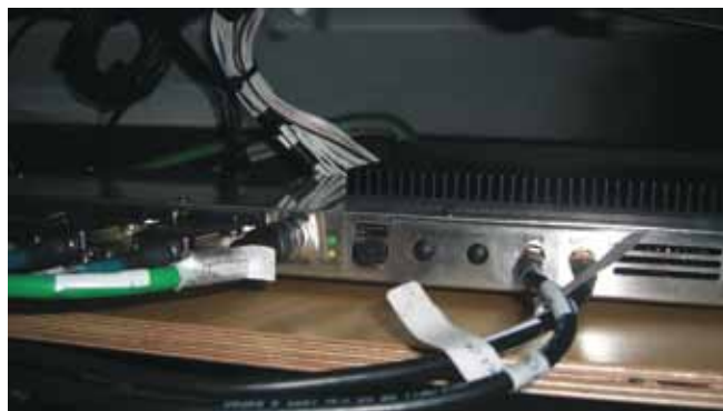
Bild 4: Einbau InfoVision PC
